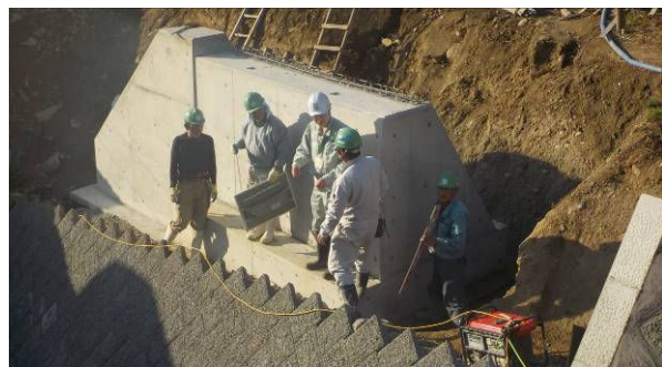
●農道橋の復旧状況
