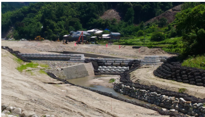
▲赤谷川の仮復旧状況（仮設の土砂溜め、護岸）
