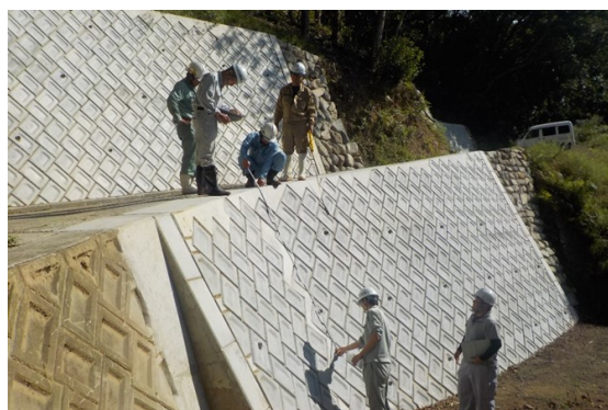
●完了検査の状況
