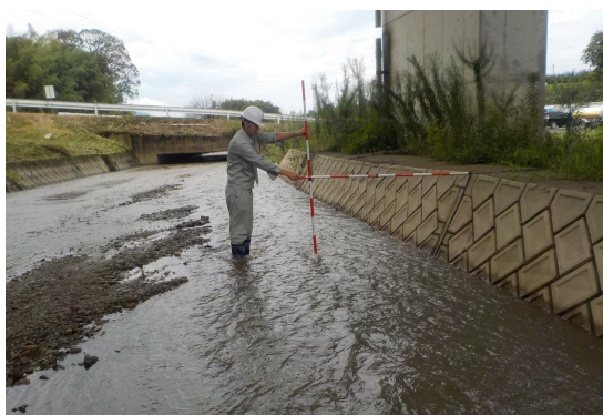
●河川埋塞調査状況
