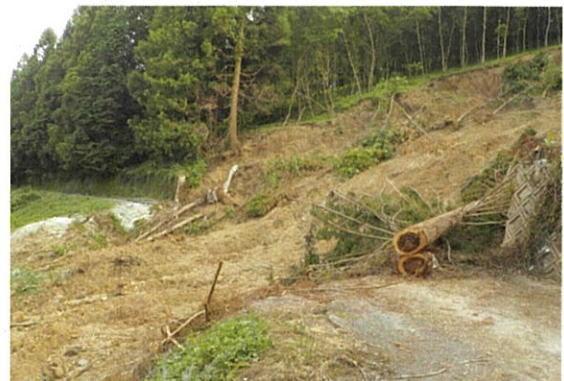
●農地や農道へ土砂が流れ込んでいる様子
