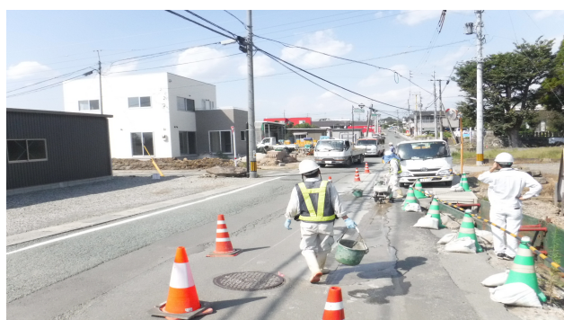
○ 道路工事と架空線工事が同時施工されている様子
