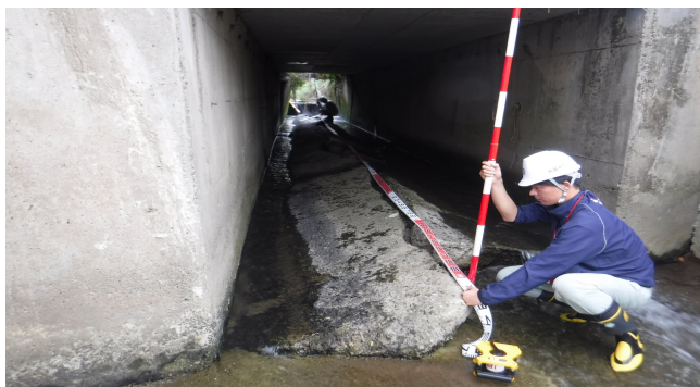
○ 河川構造物の断面を測量している様子
