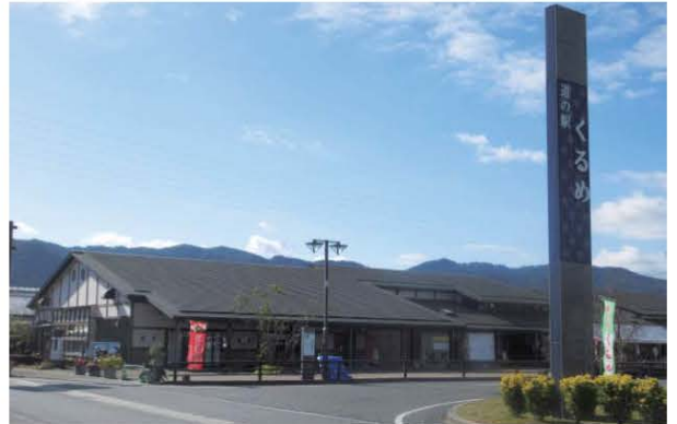
道の駅くるめ
