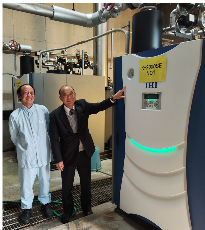
2022年に設置した天然ガスボイラー
