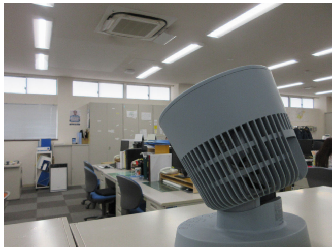
改修後に導入したサーキュレーター
