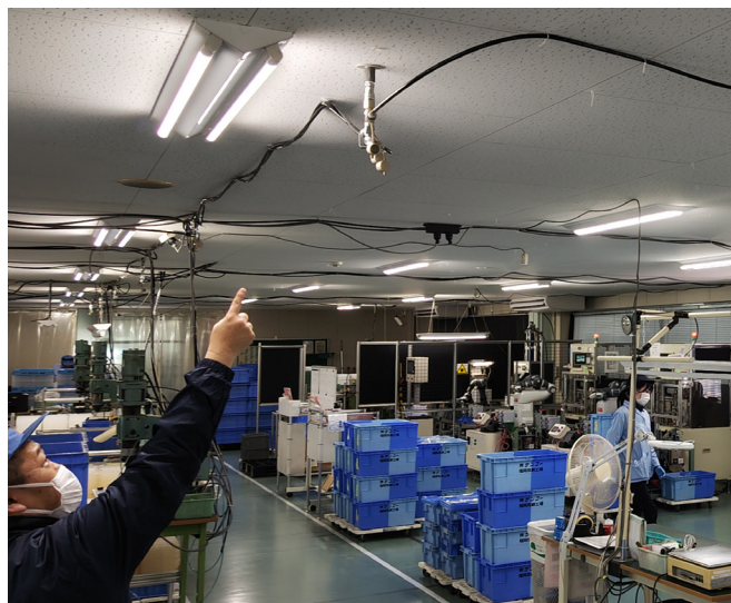
工場内の照明も全てLEDに変更しました
