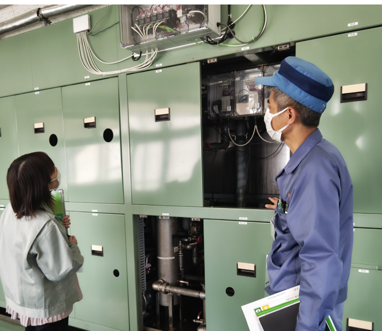
モーター状態監視装置。モーターの劣化具合を「見える化」する装置
